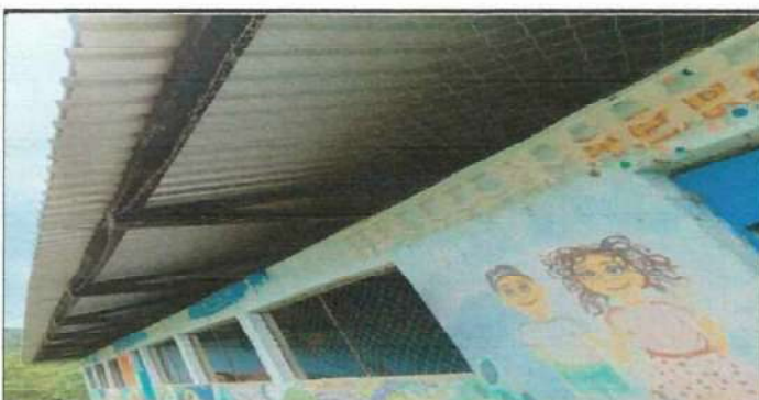
Foto 6: COLOCACION DE BALCONES EN VENTANAS
