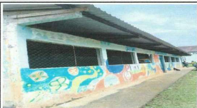
Foto1:REHABILITACION DE PAREDES DE AULAS
