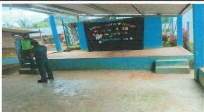
Foto 3: MANTENIMIENTO A CUBIERTA DE LAMINA
