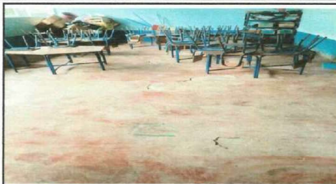
Foto 2: SUSTITUCION DE PISO A PISO CERAMICO
