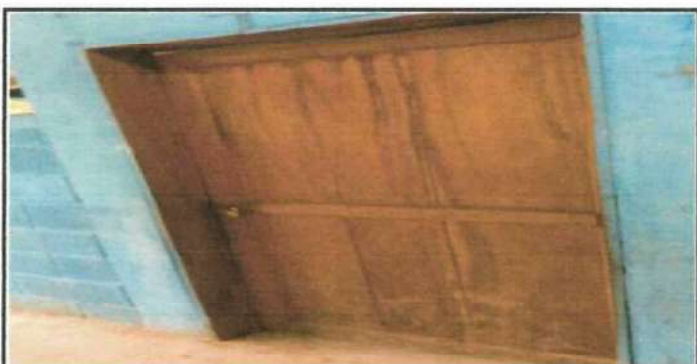
Foto 5: SUSTITUCION DE PUERTAS DE MADERA A METAL
