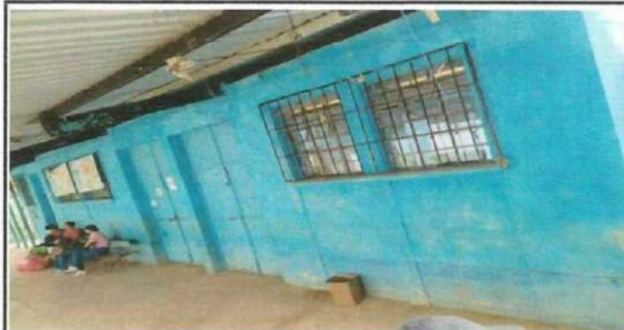
Foto 4: MANTENIMIENTO DE PINTURA DE PAREDES EXTERIORES Y INTERIORES
